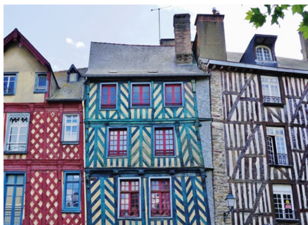
Construction en pan de bois
