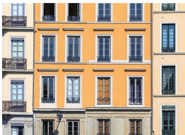
Construction en pierre
