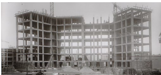
HBM Structure poteaux-poutres en béton
