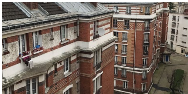
HBM Façades en briques
