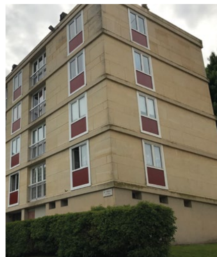
Construction en béton des années 60
