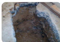
Réalisation de l'excavation sous dalle
