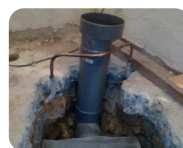
Mise en place du puisard
