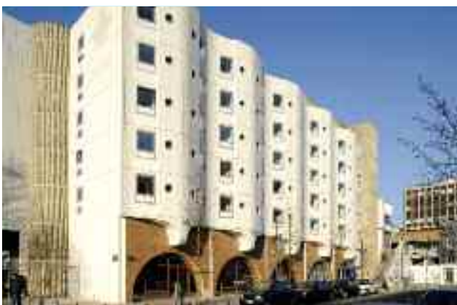
Résidence Evry Centre Agora, à Evry (91), certifiée Patrimoine Habitat pour IMMOBILIERE 3F, architecte Sylvain Bothereau, photo Groupe 3F/Frédéric Achdou.
