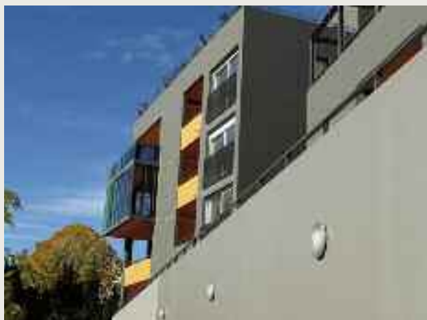
Résidence Le Moulin de Semalem, à Montpellier (34), certifiée NF Logement pour ROXIM, architecte SCP Cusy Malaval, photo ROXIM PROMOTION
