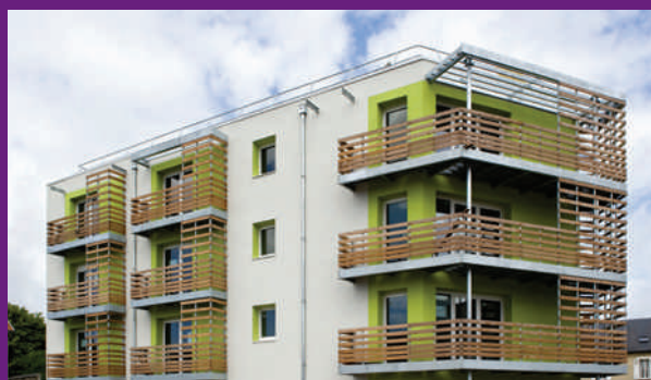
Résidence Cormellia, à Caen (14), certifiée Qualitel BBC Effinergie pour CAEN HABITAT, Architecte Cabinet Nicolas Mettereau, Photo Antoine Cardé
