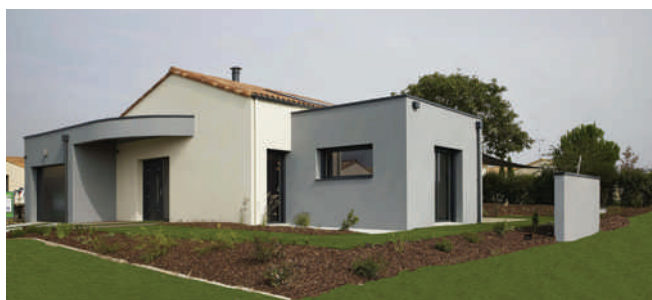
Maison NF HQE BBC-Effinergie conçue et réalisée par l'Entreprise LA BOCAINE (85)
