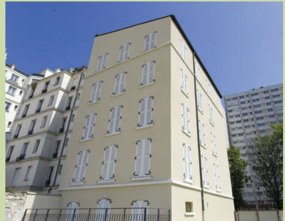
Résidence 9 Rue des cailloux, à Clichy sur Seine (92), certifiée Patrimoine Habitat pour IMMOBILIERE 3F, Architecte Pierre DOUAIRE, Photo 3F/Cyrille Dubreuil
