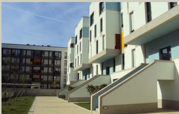
Résidence Berthe Morisot, à Montfermeil (93), certifiée Qualitel HPE 2000 pour Office Public de l'Habitat de Seine Saint-Denis, Architecte Vincent Cornu Architecture, Photo OPH de Seine Saint-Denis
