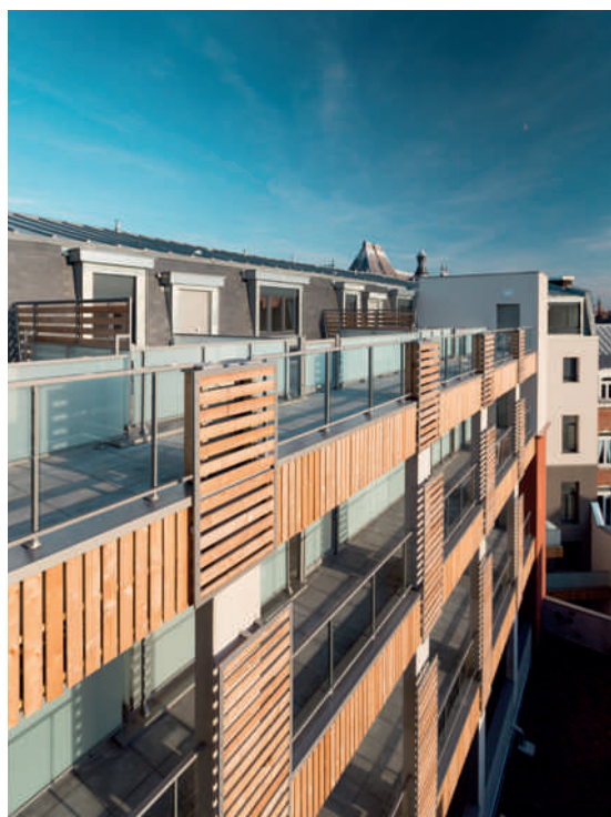
Place de la république à Lille (59), certifié Patrimoine Habitat & Environnement Effinergie Rénovation, pour CIRMAD, architecte Agence MAES, photo Laurent GHESQUIERE www.JeConnaisUnPhotographe.com
