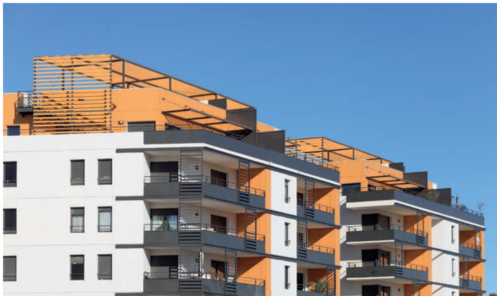
Les Clarylis à Montpellier (34), certifié NF Logement HPE 2005, pour CORIM, architecte C. MARMEY, photo J.L. GIROD
