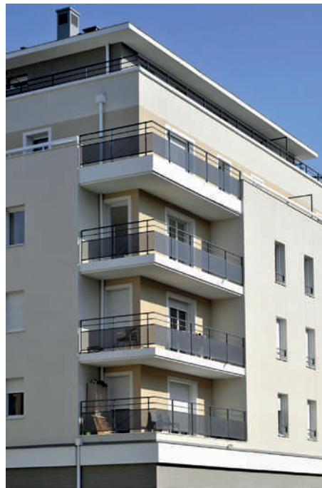
Noisy le Grand 4981L à Noisy le Grand (93), certifié Qualitel BBC-Effinergie et Habitat & Environnement BBC-Effinergie, pour IMMOBILIERE 3F, architecte Agence Gérard de Cussac, photo 3F / ACHDOU Frédéric / URBA IMAGES
