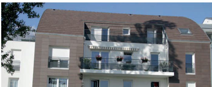
L'Orée du Bois à Limeil Brevannes (94), certifié Qualitel THPE 2005 et Habitat & Environnement THPE 2005, pour LES NOUVEAUX CONSTRUCTEURS, architecte M. PEZIN de ARC.AME Paris - photo : Les Nouveaux Constructeurs
